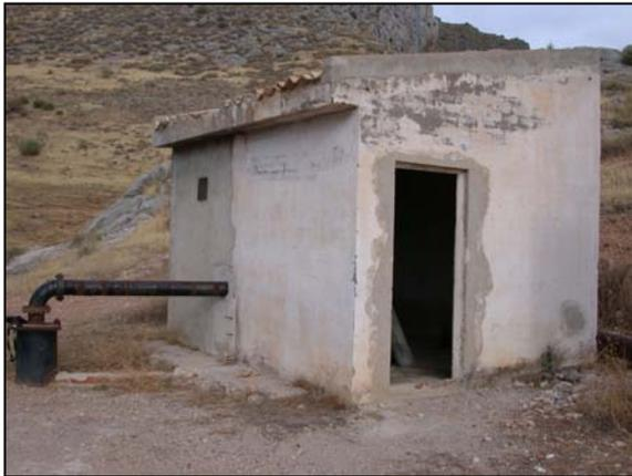
Su caudal de explotación es de aproximadamente 15 l/s (según informador municipal). Está instalado con una electrobomba sumergible de potencia desconocida. La tubería de impulsión es metálica.
