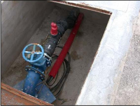
Su caudal de explotación es de aproximadamente 38 l/s (según informador municipal). Está instalado con una electrobomba sumergible de 100 C.V. de potencia. La tubería de impulsión es metálica.
